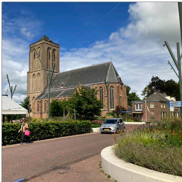
Ruimte groenbakken, centrum Didam
